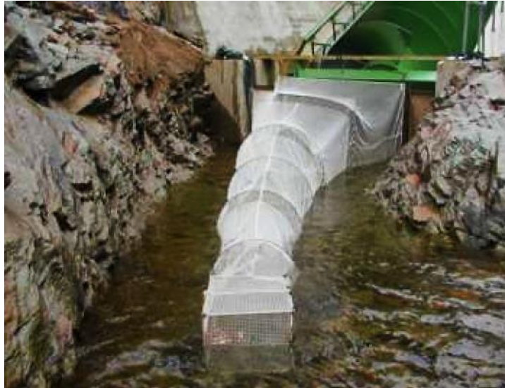
Abbildung 4: Auslaufbereich einer Wasserkraftschnecke am Fluss Dart – Schwimmschwache Fische können sich bei ungünstigen Strömungsverhältnissen an den Felsen verletzen (Quelle: [3])
