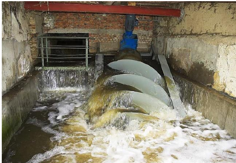
Abbildung 6: Auslaufbereich einer Wasserkraftschnecke an der Wörnitz – Positiv ist, dass keine Hindernisse im Auslaufbereich vorhanden sind, negativ ist die geringe Einbautiefe bei normalen Abflüssen (Quelle: [6])
